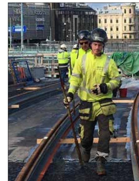
David Stålhandske och Arild Horn jobbar för att få spåret på plats på nya Hisingsbron.
