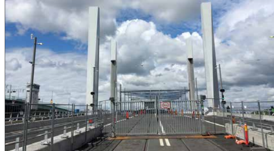
Den nya Hisingsbron är öppen för vägtrafik, men ännu pågår spårarbetena.
