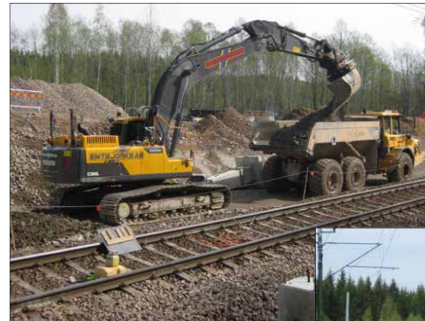
Ncc sätter kontaktledningsfundament på nya driftplatsen Sandmon. Entreprenör Stefan Hedlund på Emtbjörks AB gräver och Jonny Karlsson på Forsås kör dumper.
