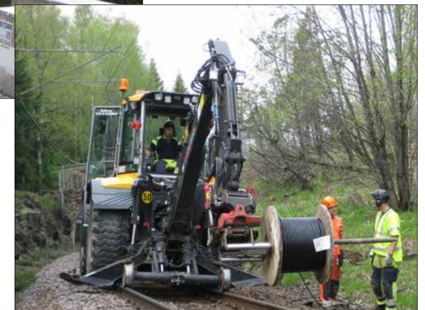
Signaltekniker Robin Wahlström på Infranord tillsammans med maskinförare Kenny Claesson och yrkesarbetare Jonas Olsson från entreprenör Hedbergs Gräv och Lasttjänst plöjer signalkabel vid Mölnbacka.
