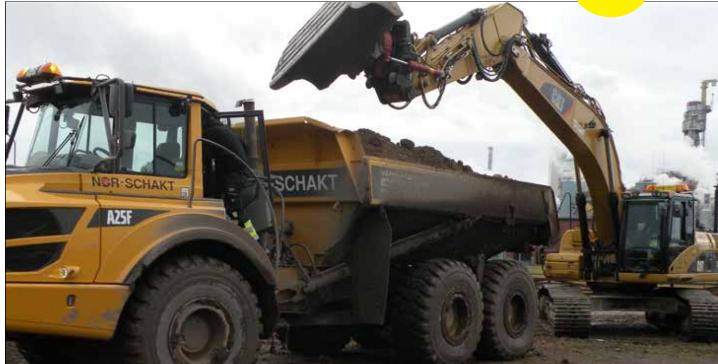
Dumperföraren Pontus Åkerlund och Grävmaskinisten Henrik Broman, i full gång att flytta massor.
