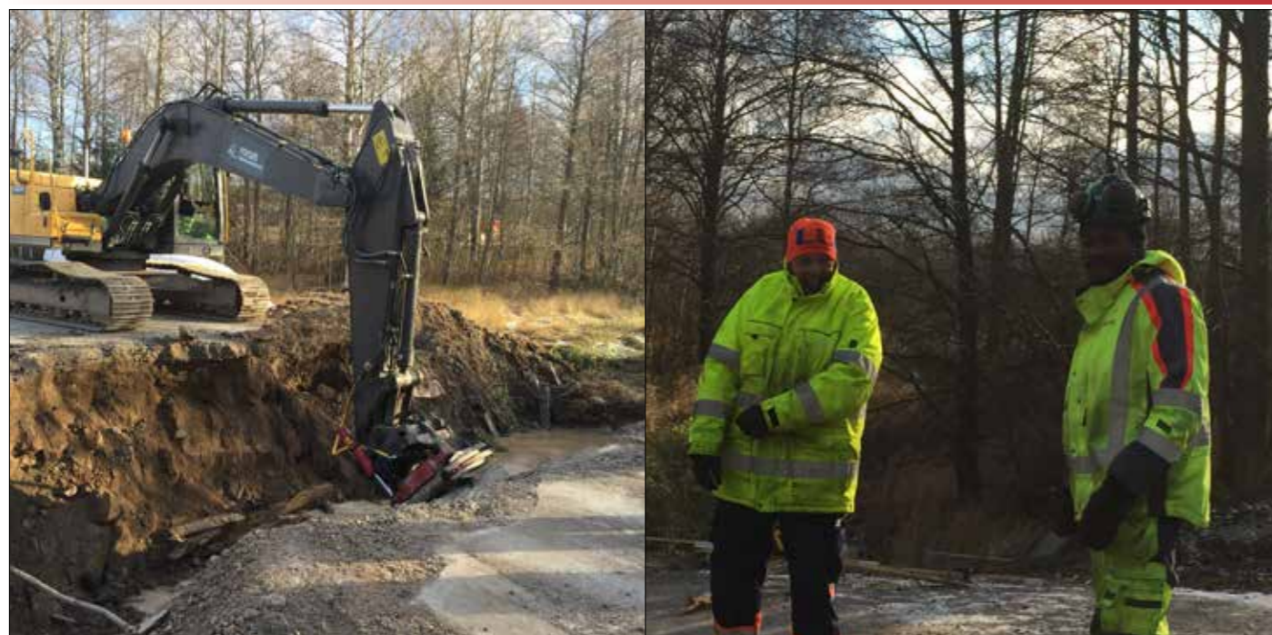
Forsås Entreprenad är med och gräver, när Svevia byter vägtrummor vid Kyrksten på väg 607. Bild: Magnus Juhlin Text: Magnus Ljungstedt
