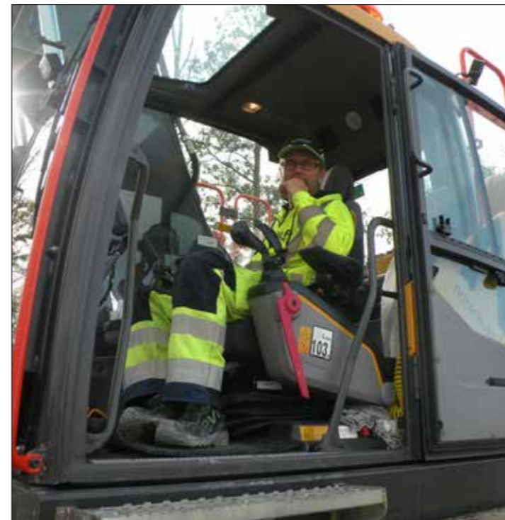
Fredrik Gustavsson Nor-Schakt är med och bygger ny ICA-affär och anslutningsvägar. Med var även Tommy Johansson från Sten&Vägarbeten. (Utanför bild) Foto&Text: Magnus Juhlin
