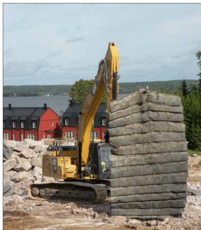
Jimmie Lundberg Nor Schakt, flyttar en sprängmatta! Skanska förbereder för nytt bostadsområde! Foto&Text: Magnus Juhlin
