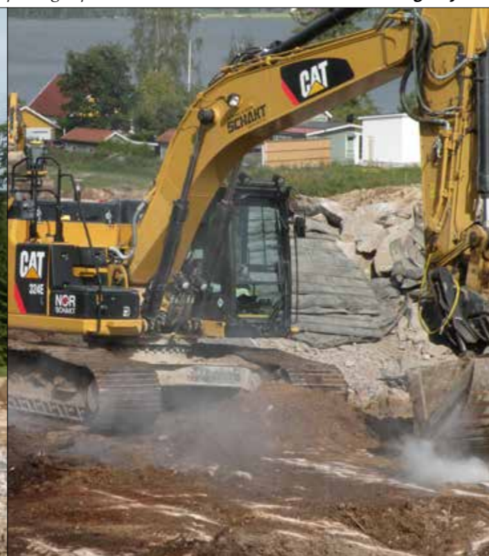
Oscar Persson rensar berg inför sprängarbeten! Skanska lägger nytt vatten, avlopp och bygger gator för nytt bostadsområde vid Edsgatan! Foto&Text: Magnus Juhlin
